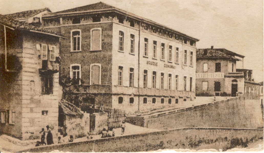
Grana Monferrato - Edificio scolastico
